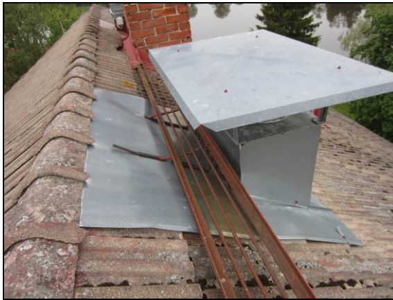
Kuva 27. Yläpohjan kulkusillat.
