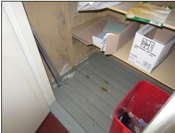
Kuva 9. Ulkoseinän vierustalla välipohjarakenteessa on kosteusjälkiä.
