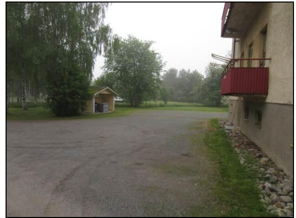
Kuva 4. Nurmi on osittain levinnyt päällysrakenteiden puolelle.
