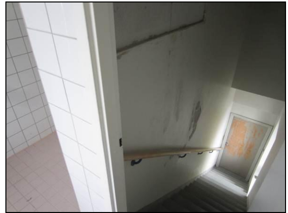
Kuva 33. Porrashuone. Seinässä kosteusvauriojälki suihkujen kohdalla ja portaissa on myös kosteusjälki.
