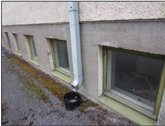
Kuva 15. Kellarin ikkunapellit ovat vääntyilleet ja kolhiintuneet.
