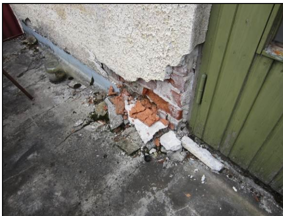
Kuva 13. Parvekkeen kohdalta seinärappaus on irti.
