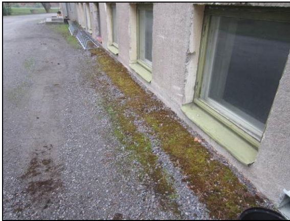
Kuva 3. Rakennuksen vierellä päällysrakenteet ovat sammaloituneet.
