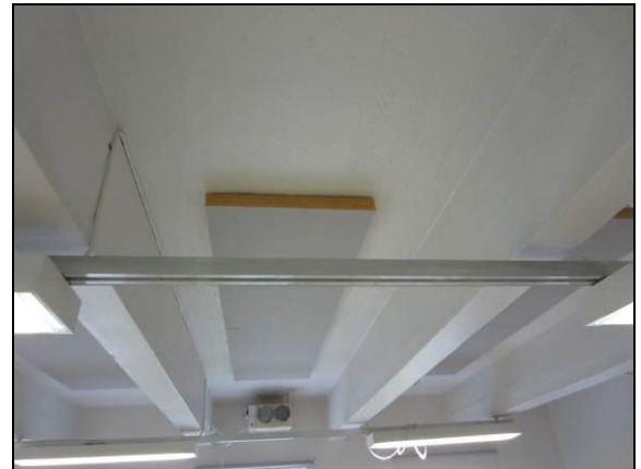
Kuva 10. Välipohjan ylälaatta-palkisto.
