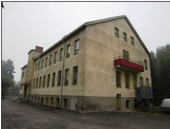
Kuva 11. Julkisivu. Seinässä on halkeamia ja rapautumaa.
