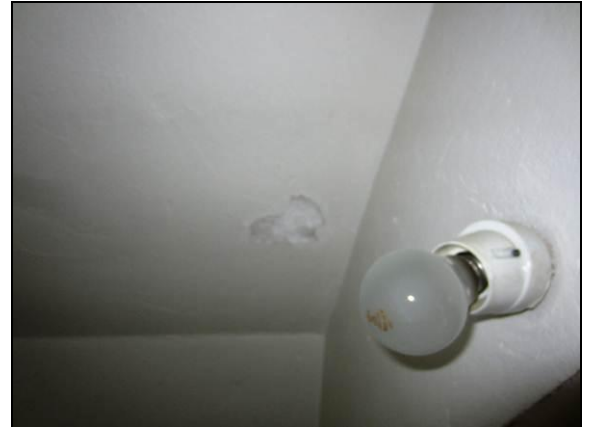
Kuva 22. Vuotojälki ullakkohuoneiston katossa.
