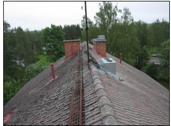
Kuva 24. Yleiskuva vesikatosta. Antenni on tipahtanut ja läpiviennin pellitys on osin irronnut.
