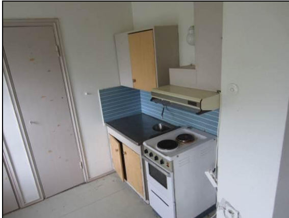
Kuva 42. Yleiskuva, ullakkoasunnon keittiö.
