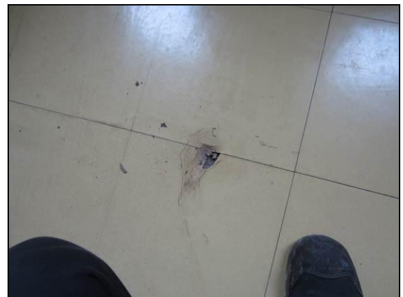
Kuva 37. Lattioissa on paikoin vaurioita.
