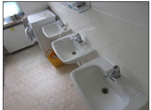
Kuva 47. Pääosa sekoittajista on käyttökänsä lopulla.
