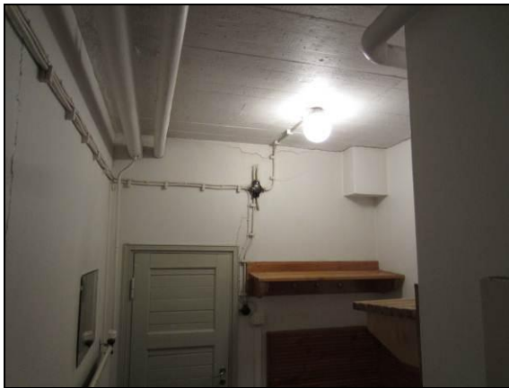
Kuva 56. Alkuperäistä johdotusta saunatiloissa.
