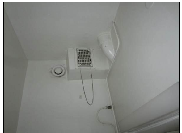
Kuva 49. Alkuperäinen (oik) ja uusittu poistoilmakanava.
