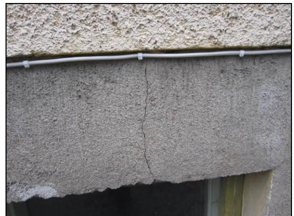
Kuva 14. Vaurioitunut julkisivu.
