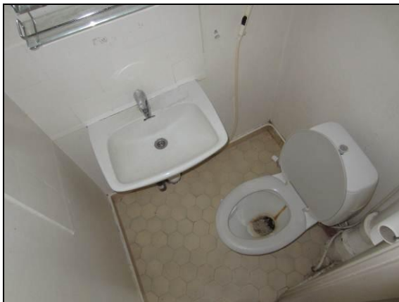
Kuva 46. Vesikalusteet alkavat olla teknisen käyttökänsä lopussa.
