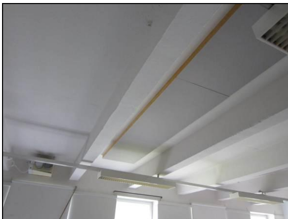
Kuva 36. Katon akustolevyjä.
