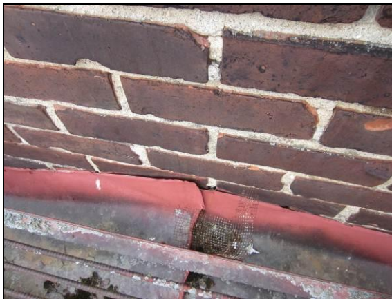
Kuva 25. Piipun rintataite, pellitys ei ole tiivis.
