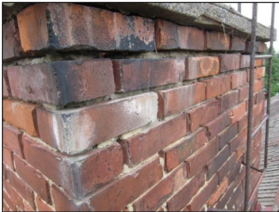
Kuva 31. Hormin yläosa on rapautunut.
