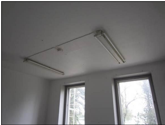
Kuva 59. Vanhat loisteputkivalaisimet.
