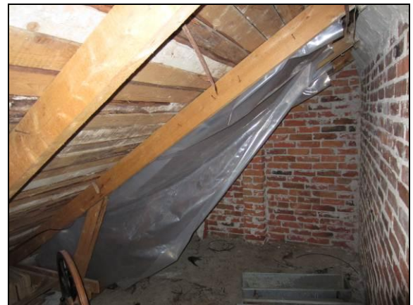
Kuva 26. Vuotokohtia on yritetty korjata muovin avulla alapuolelta.
