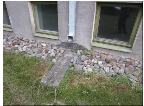
Kuva 28. Syöksytorvi kastelee kellarin seinää.
