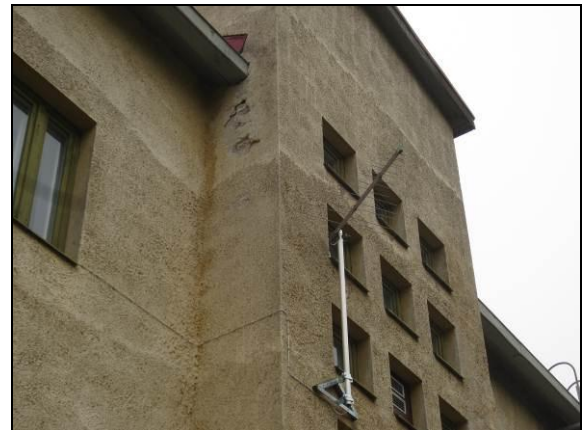
Kuva 12. Seinä on paikoin rapautunut.
