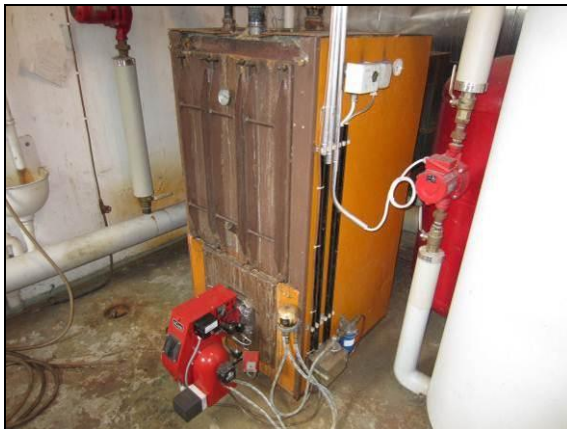
Kuva 44. Lämmityskattila.
