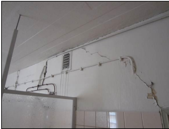
Kuva 38. Kellarin pesuhuoneen seinä on halki.
